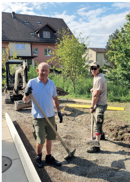
Rümlang: Bau der Boccia-Bahn
